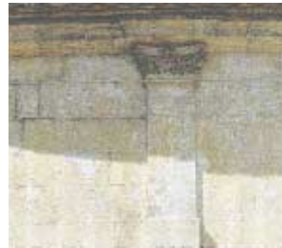
Moellons appareillés.
